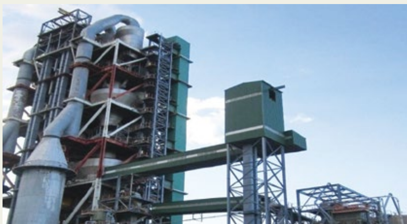
Σύστημα τροφοδοσίας εναλλακτικών πρώτων υλών και εναλλακτικών καυσίμων
